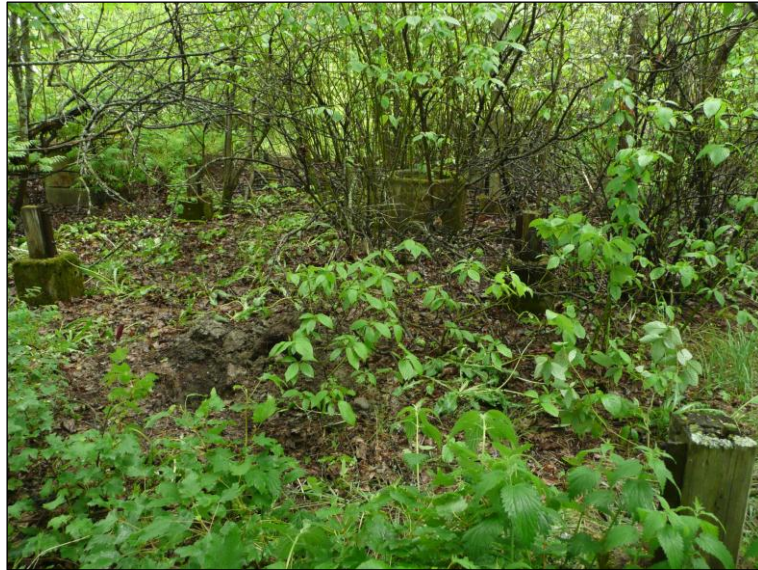
Rakennuksen betoni- ja puurakenteita tontin länsiosassa
