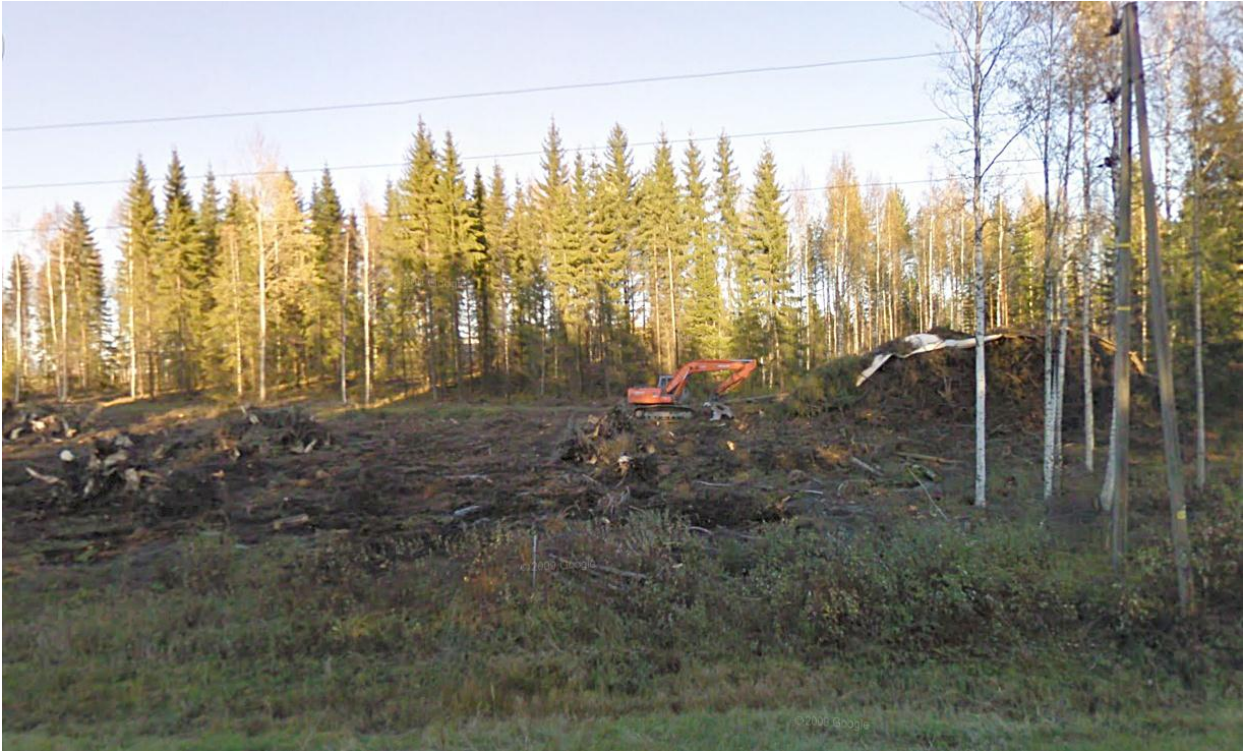
Vanha tielinja kulkee metsätienä taustalla, hakatun metsän reunan ja kaivinkoneen välillä. Kuvattu n. 150 m vt 3:n ja Häijäntien risteyskosen luoteispuolelta koilliseen.
