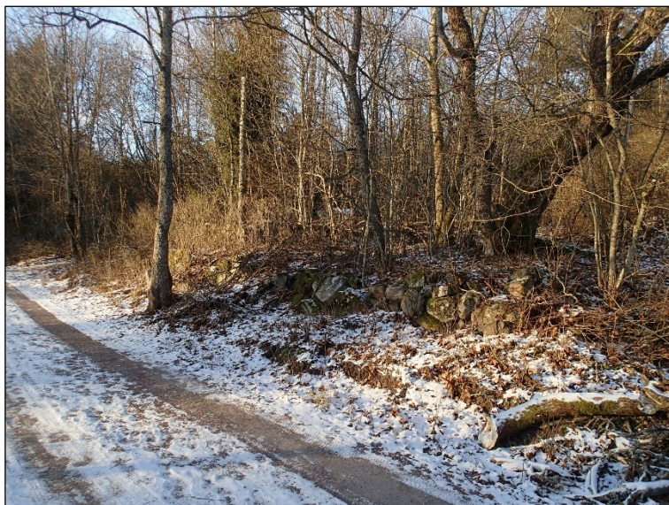
Kuvaussuunta luoteeseen. Tien varren kivisiä rakenteita.
