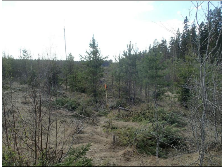
Kuva paikasta N 7137268 E 356097 suuntaan 204, sähkölinjaa
