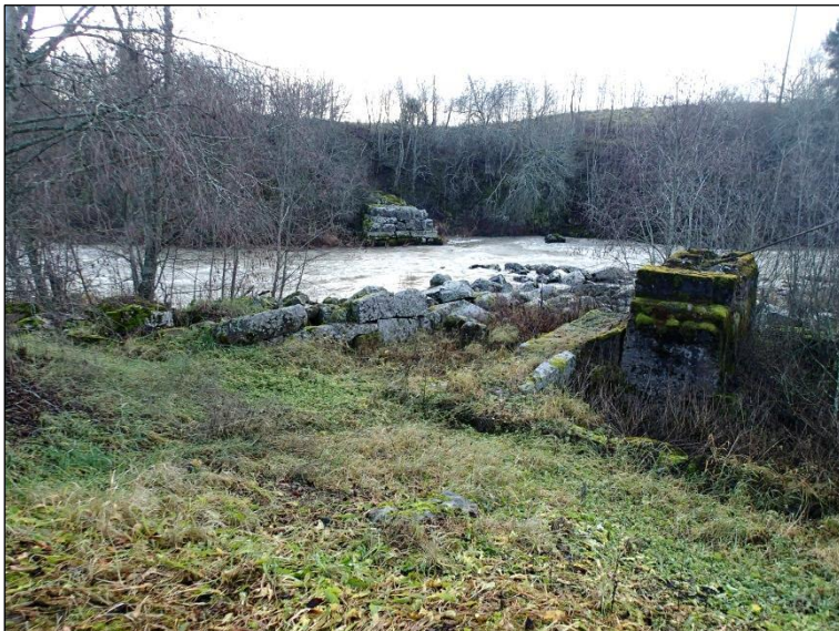
Raunion Koivukylän alemman myllyn paikan rakennusten ja padon jäänteitä. Kuvattu etelään.
