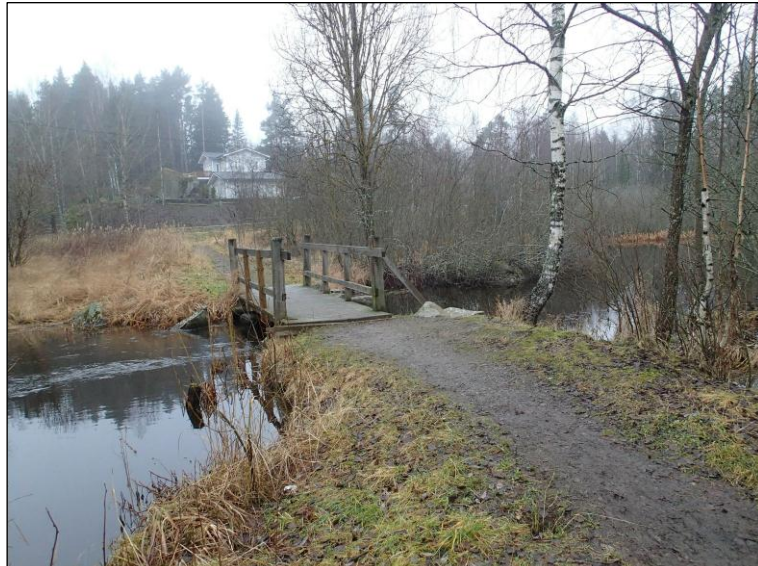
Nykyinen silta Moisionjoessa Hiidentien linjauksen paikkeilla
