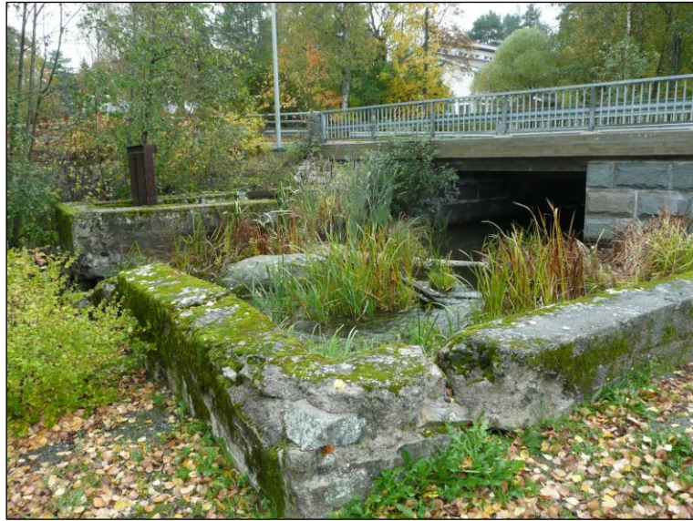
Betonirakenteita sillan eteläpuolella
