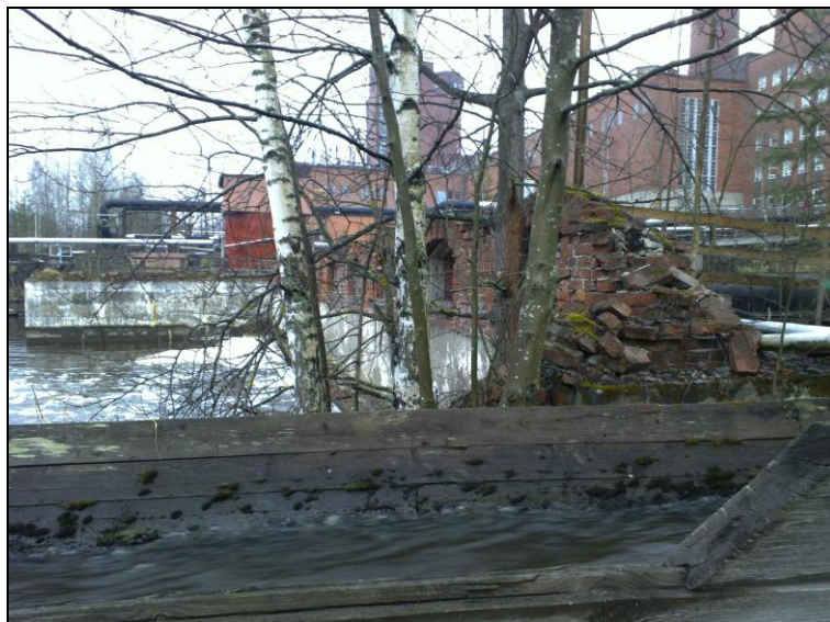
Saaren länsipäästä, vanhan voimalaitoksen pohjoisseinämä jäänteet.
