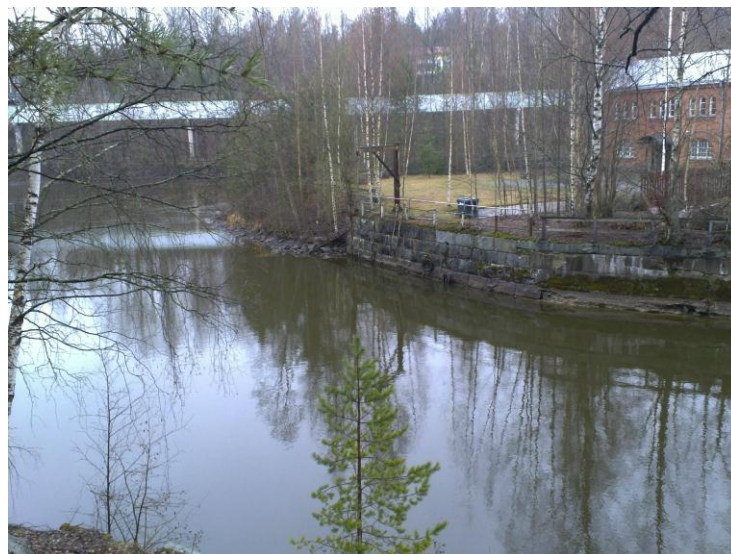
Neulapadon paikka kuvan keskellä saarella olevan vanhan nostotaljan kohdalla.
