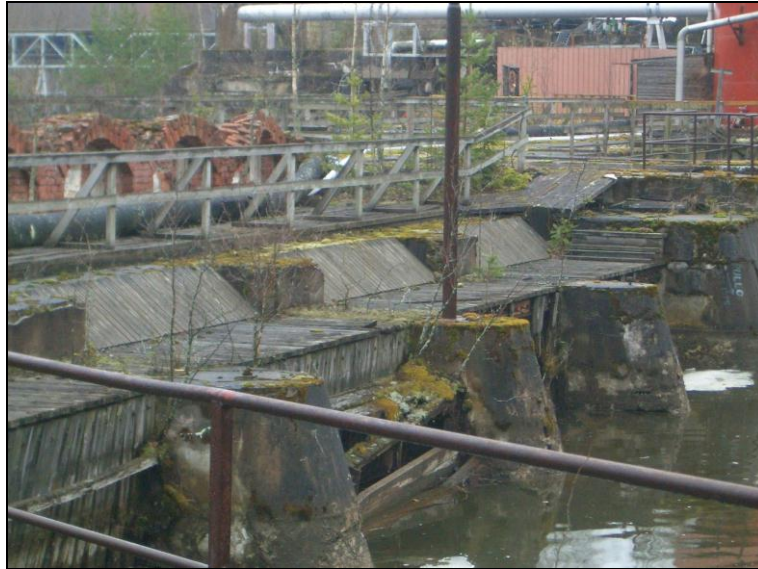
Vanhan voimalan pohjoisseinän jäänteiden pohjoispuoli.
