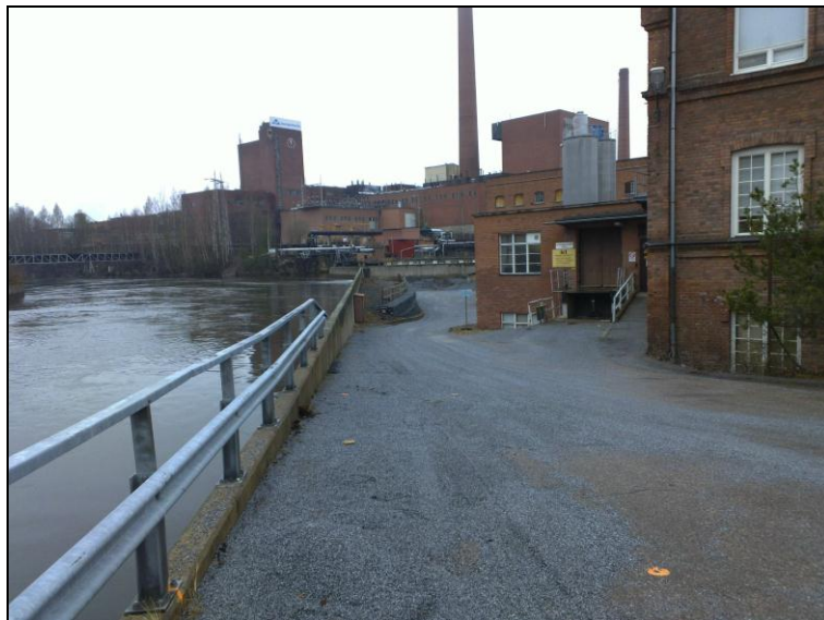
Ruiskuhuoneen paikka etualalla. Länteen sillan päästä.
