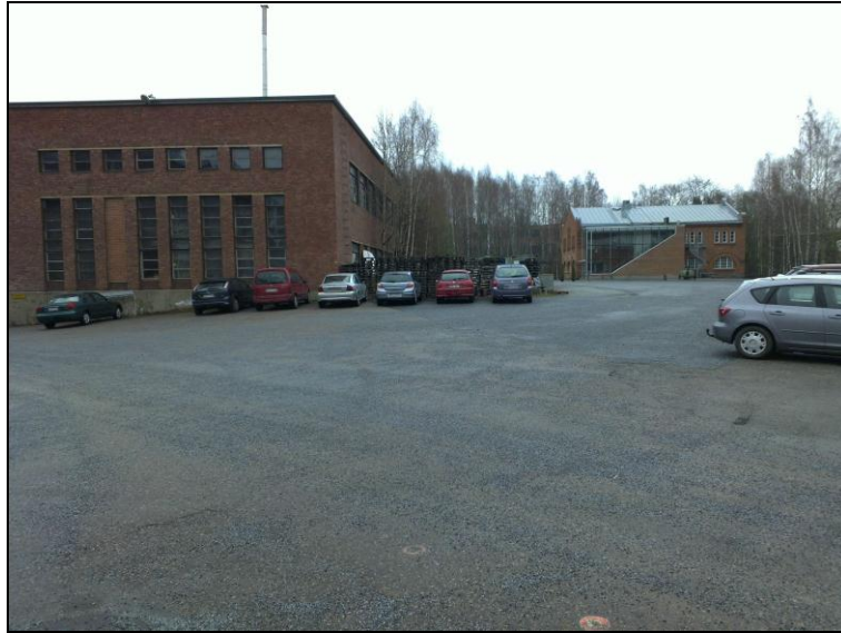
Aluetta jossa vesitorni ja käytettyjen koneiden varasto. Sillan päästä koilliseen.
