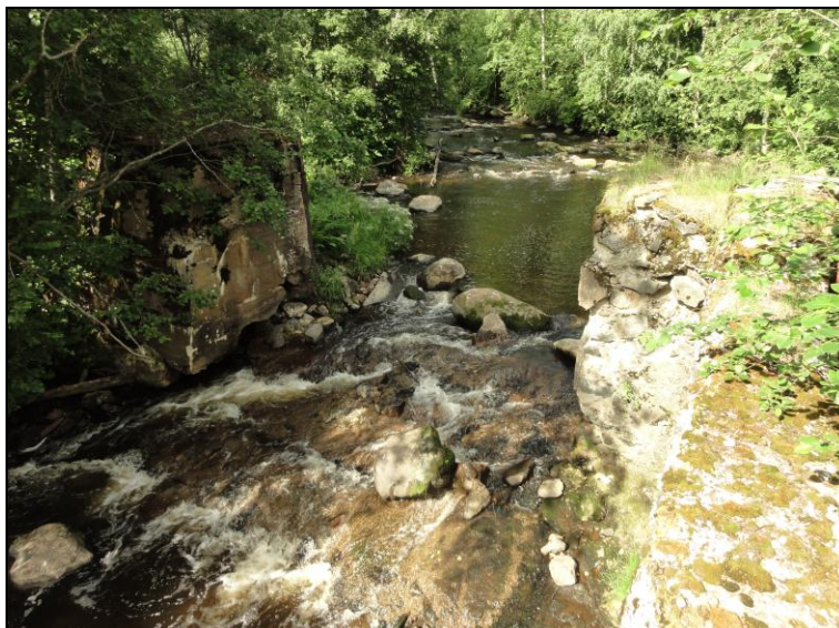
Voimalaitokseen liittyvää uomaa, seinää ja patorakennelmia
