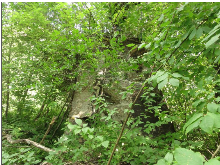
Osittain sortunutta betonista patorakennelmaa sen keskivaiheilla.
