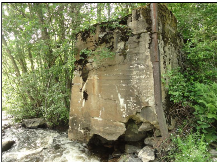
Voimalaitoksen patorakennelmaa laitoksen uoman lounaispuolella
