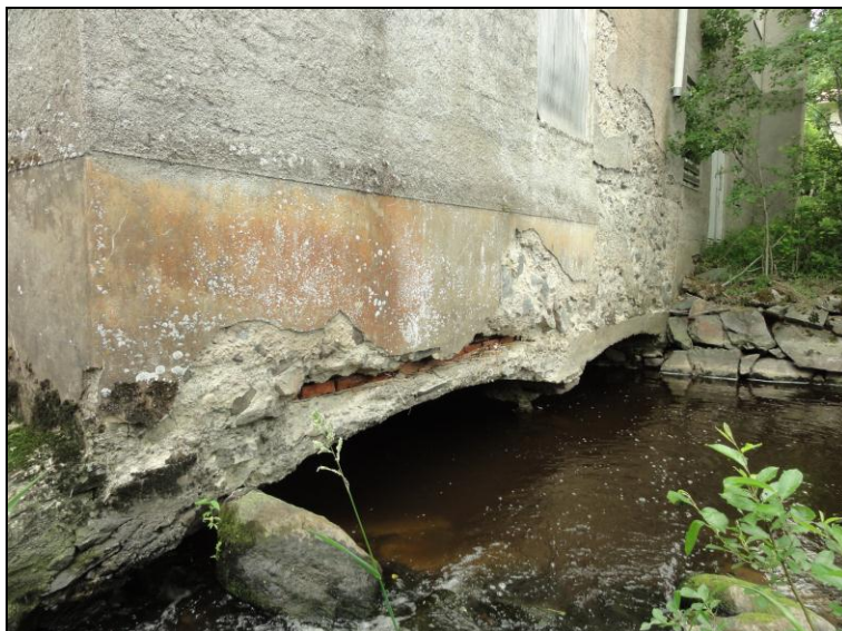
Voimalaitoksen betoni- ja tiiliseinää, uomaa ja sen reunuskiveystä.
