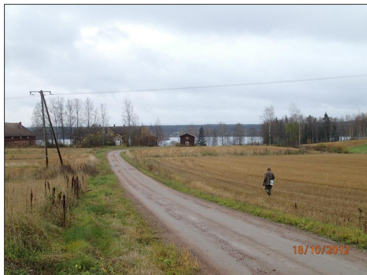
Viemäri linja kulkee tien vierellä pellossa. Sänkipellosta havaintoja saattoi saada vai rajoitetusti.
