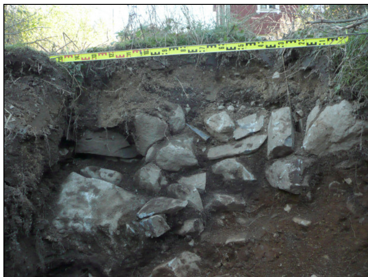
Koeoja 2 pohjoispääty. Tien perustamiskiveystä.
