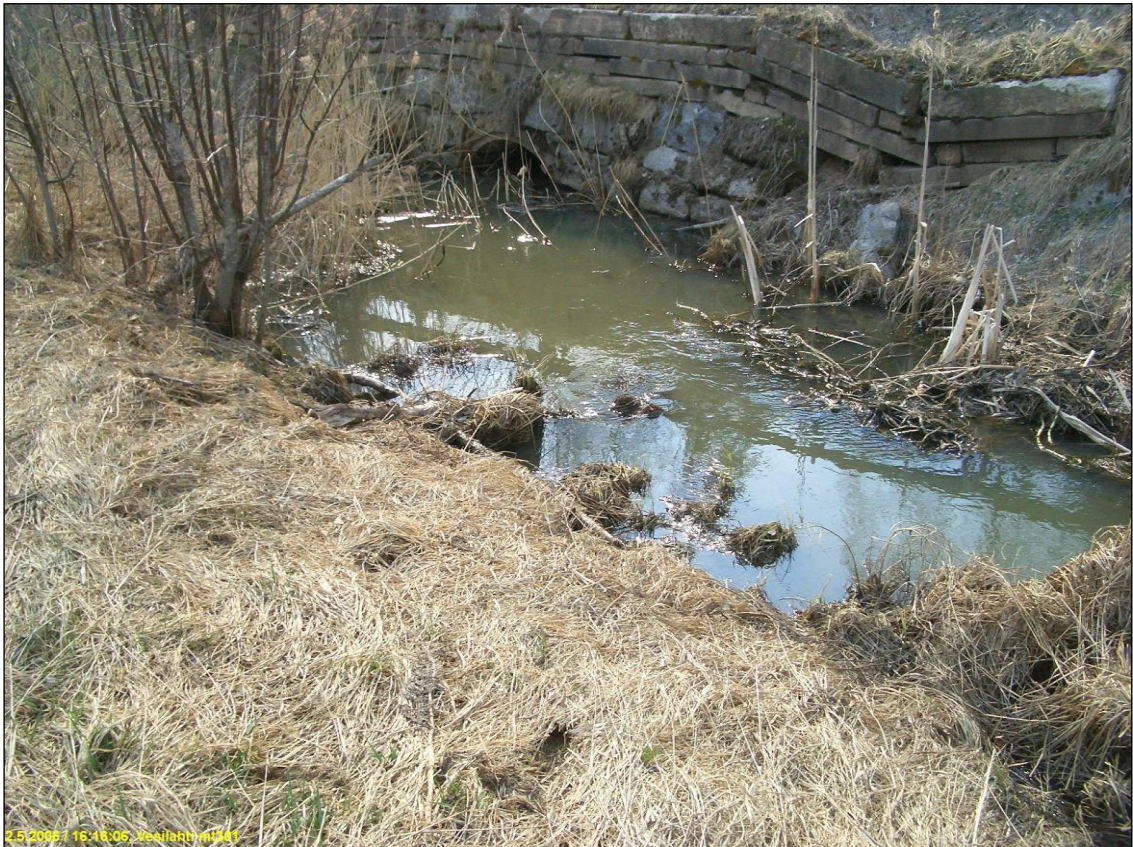
Mt. 301 Lihmonojan siltarumpu v. 2006
