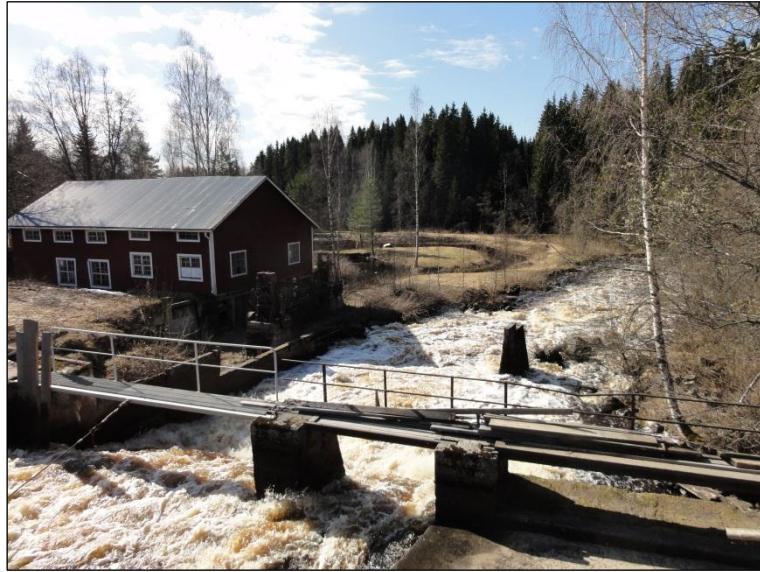
Jyllinkosken mylly sillan eteläpuolella. Alue raskaasti muokattu, mm. betonirakentein.
