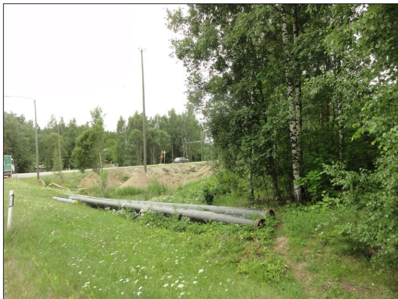
Ponsantieltä asuinpaikan suuntaan, missä kaivaus käynnissä.
