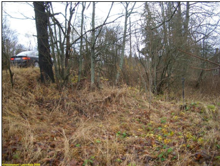
Tien varressa oleva rakennuksen perusta 2
