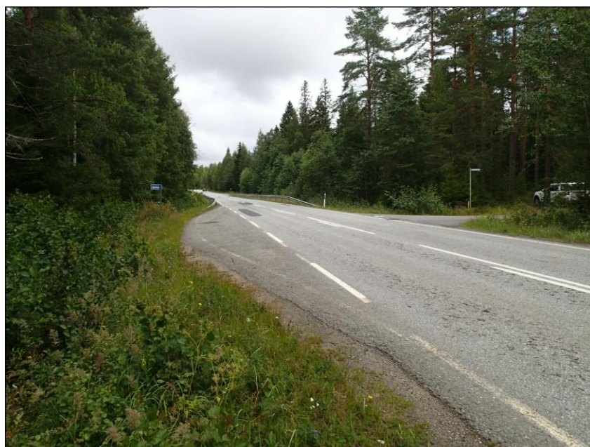
Kohde 3 kuvan keskiosassa, tienristeyksen takana olevassa metsässä ja siltakaiteiden oikealla puolella olevassa tienpientareessa. Kuvattu koilliseen.
