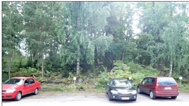
Vy mot anläggningarna A och B invid parkeringen. Från norr.
