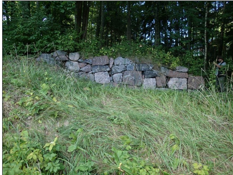
Stenmur från söder
