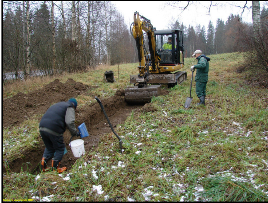
Ojaa 1 avataan. Länsipäässä, kuvattu itään. Kuvassa Schulz ja Poutiainen (valvoo).
