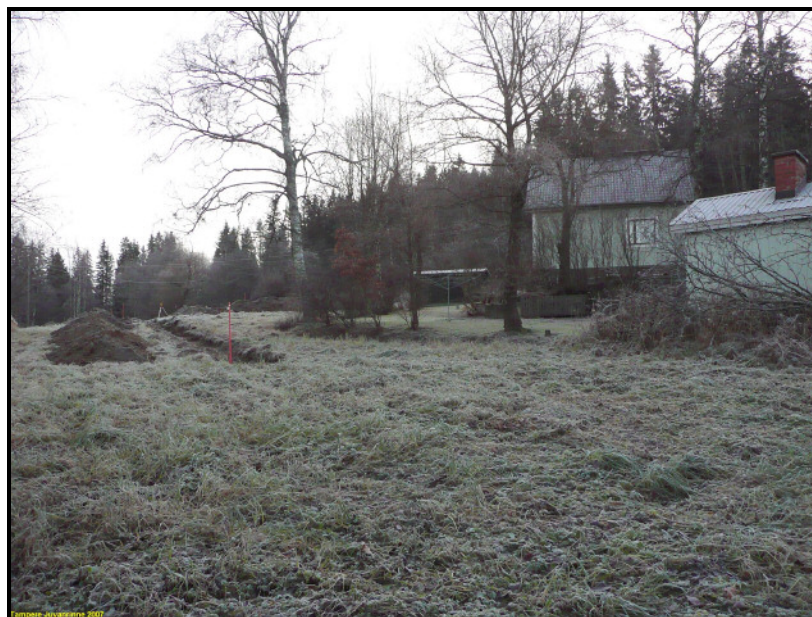
P1010571 Yleiskuva länsipäästä kun oja 1 avattu
