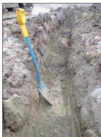
Kuva 2. Maa-kaapelilinjaa valvonnassa kaivetun linjan keskivaiheilla.
