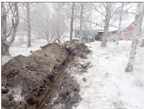
Kuva 3. Taulaniementie 343:lta kaivettu kaapelioja, kuvattuna kaakkoon.
