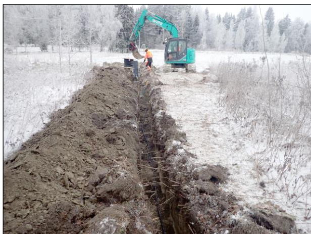
Kuva 1. Valvonnassa kaivetun ojan länsipää, kuvattuna länteen.
