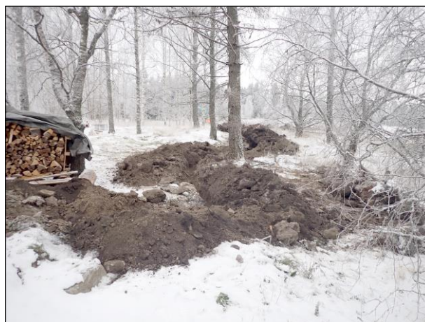
Kuva 4. Taulaniementie 343:lta tuleva kaapelioja luoteeseen kuvattuna.
