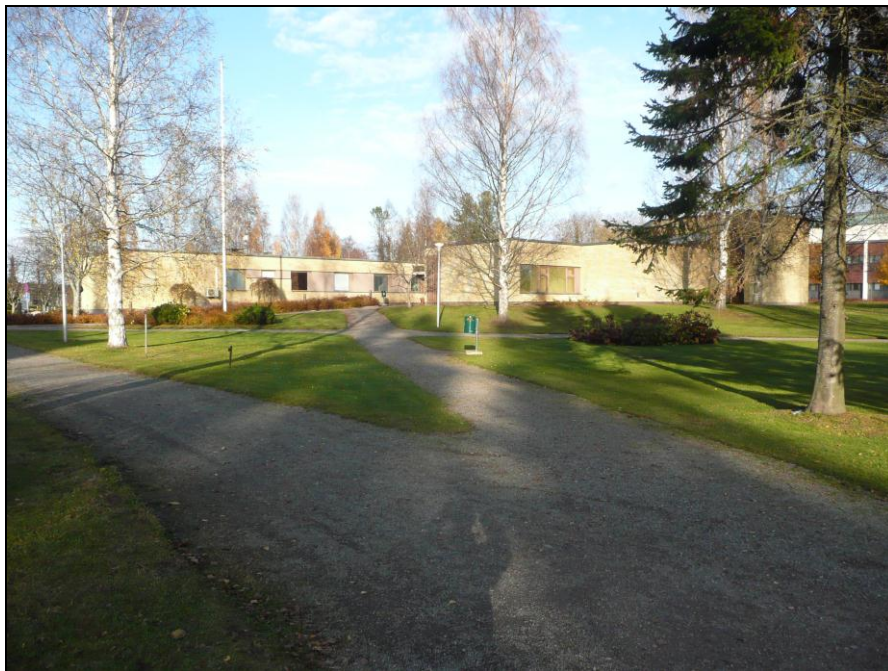
Taustalla seurakuntakeskus. Laajennus kuvaajan suuntaan. Kuvattu kirkon suunnasta koilliseen.
